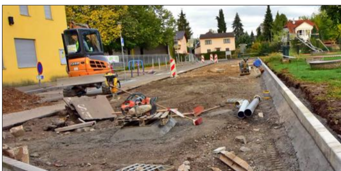
Le parking est aménagé rue Anne-de-Gohr à Bourgfelden. DR
